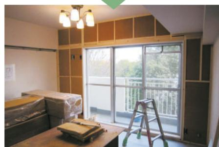
外気に面した壁の内側のみ断熱施工するので、隣家との境壁には施工しません。
