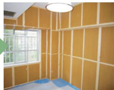
垂木を施工して、その間にウッドファイバー（木質繊維断熱材）をはめ込みます。
