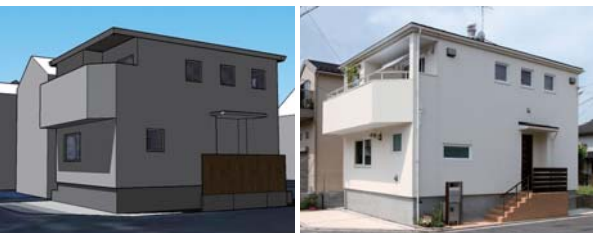
施工後との比較写真（下）。ほぼ陰の形が一致しています。
